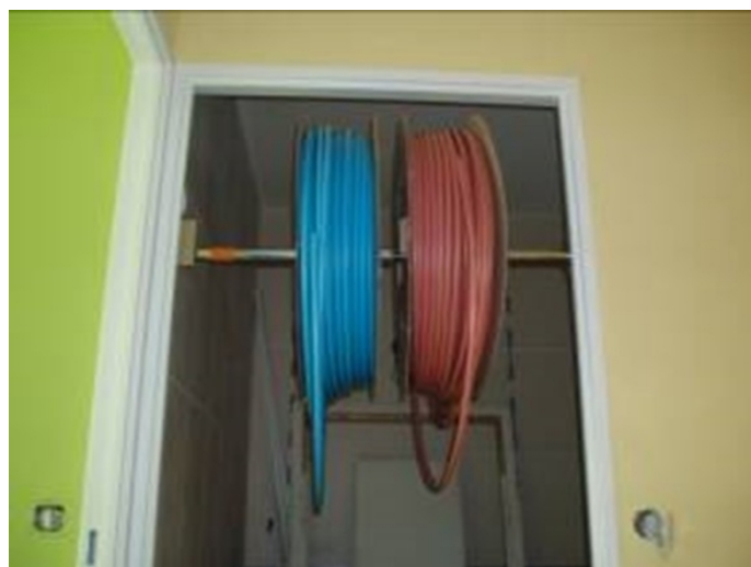
Figure 15 - Axe de déroulage des deux bobines des tubes de chauffage
