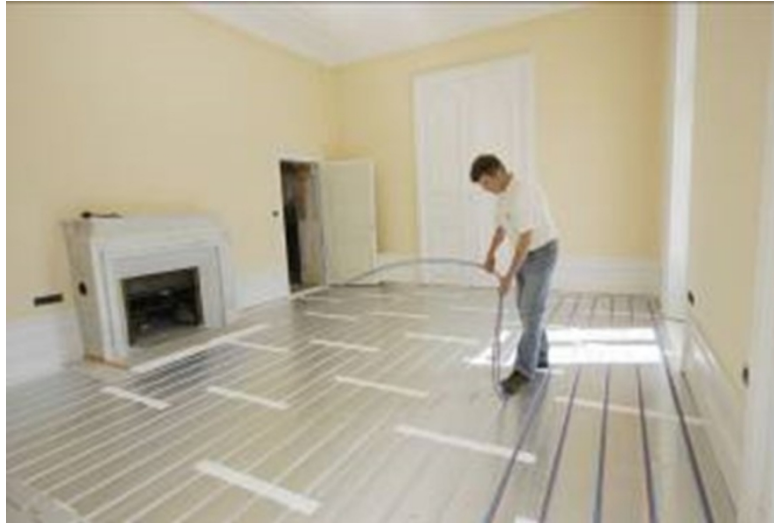
Figure 16 - Pose des tubes dans les rainures de la dalle
