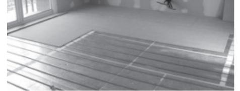
• Pose en quinconce et bord à bord des plaques ciment cellulose (partie quadrillée côté revêtement de sol)
