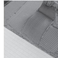
• Dans le cas de joints de dilatation et de fractionnement, nécessité de prévoir un espace de 6 mm entre plaques ciment cellulose
