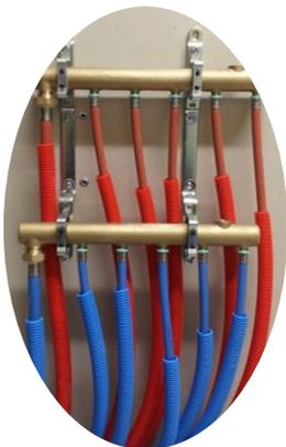
Les collecteurs laiton à sertir équipés permettent l'alimentation des radiateurs à eau chaude en haute ou basse température, l'alimentation des appareils de climatisation en eau glacée.
