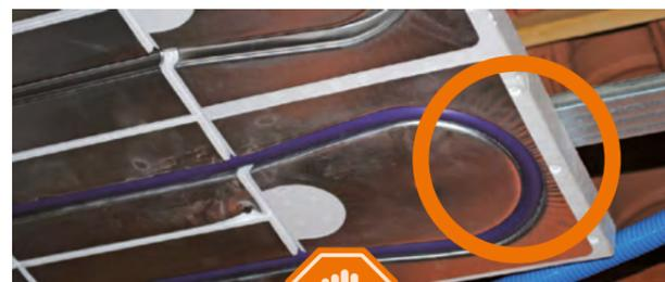
La pose des plaques de plâtre doit s'effectuer juste après la pose du système ACOSI+ (sous un délai de 7 jours maximum).
