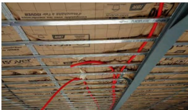
**PASSEZ** les fourreaux des entrées et des sorties des différents circuits.
