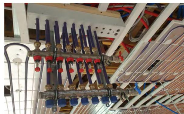
Prévoyez la mise en oeuvre d'un dispositif permettant d'assurer l'étanchéité du plafond au niveau du passage des tubes des différents circuits plafond.
